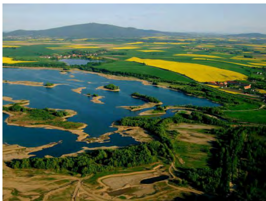
Ryc. 5.6. Poglądowy obraz akumulacji osadu w obrębie zbiornika Mietków na Bystrzycy w stanie jego niskiego napełnienia. Aluwia są eksploatowane (fot. B. Schutty, za zgodą autorki)
