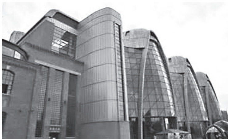
Fot. 2. Elektrownia EC-1 w Łodzi. Źródło: fotografia własna autorki.
