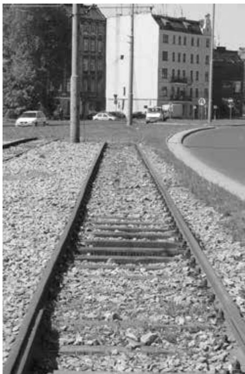
Fot. 28. Nieużywane tory tramwajowe na ul. Mieszczańskiej
