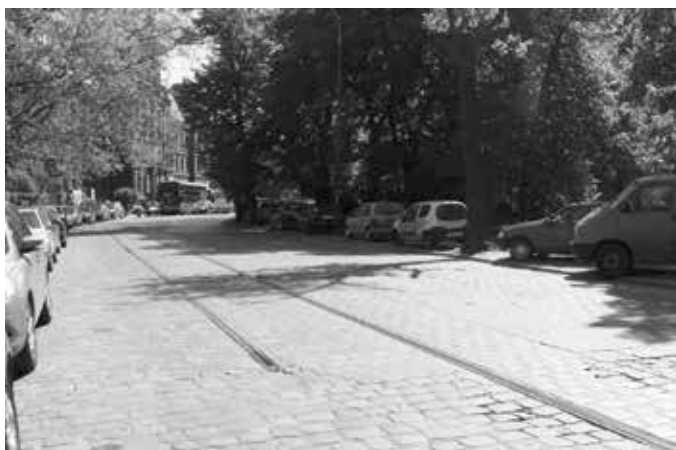
Fot. 4. Nieużywane tory tramwajowe na ul. Jana Ewangelisty Purkyniego Źródło: fot. A. Karaś.
