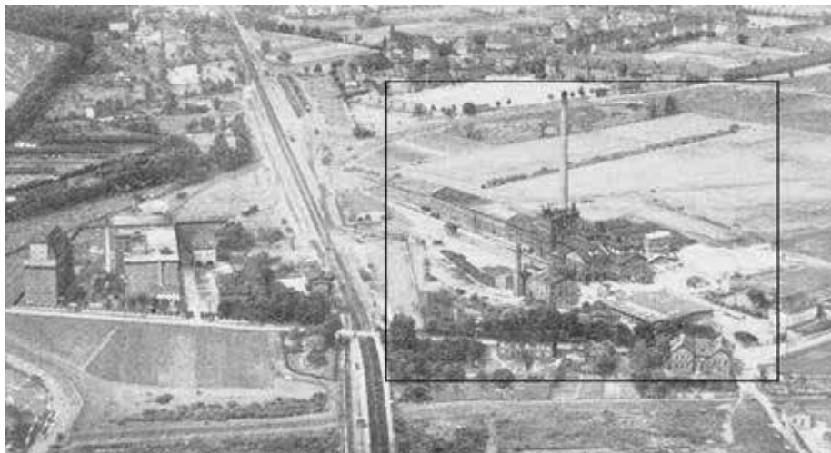
Fot. 16. Sołtysowice z lotu ptaka (lata 1920–1925) z zaznaczoną Cukrownią „Wrocław” oraz Młynem Sulikowice Źródło: Wratislaviae Amici.
