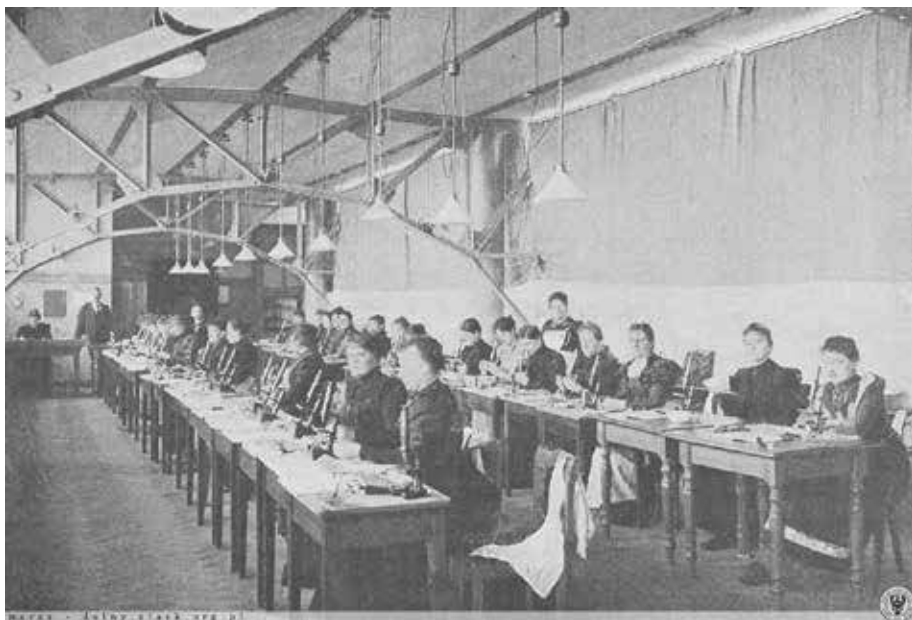
Fot. 6. Nadzór sanitarny w Rzeźni Miejskiej – stanowiska kontroli jakości mięsa ok. roku 1900 Źródło: Wratislaviae Amici.
