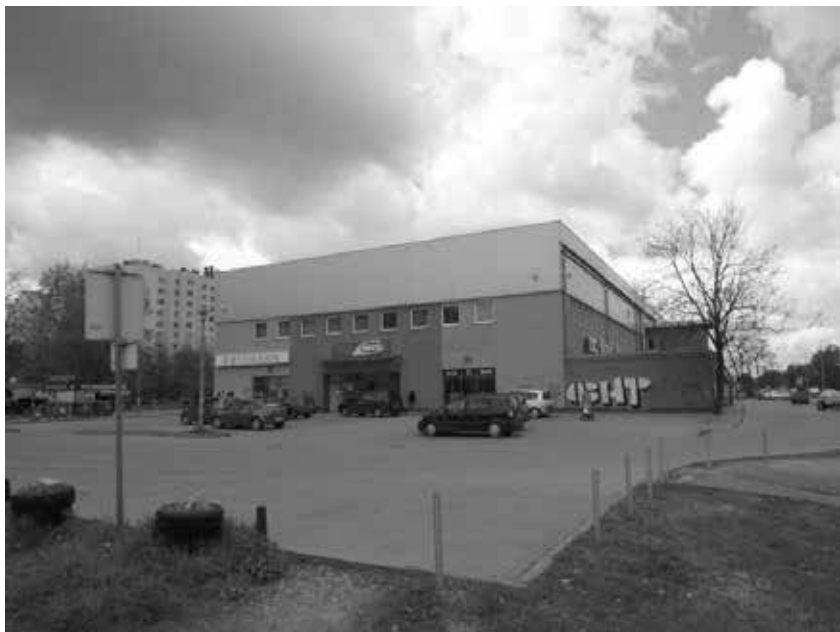
Fot. 18. Stary hangar na dawnym lotnisku Gądów we Wrocławiu Źródło: fot. M. Smolarski.
