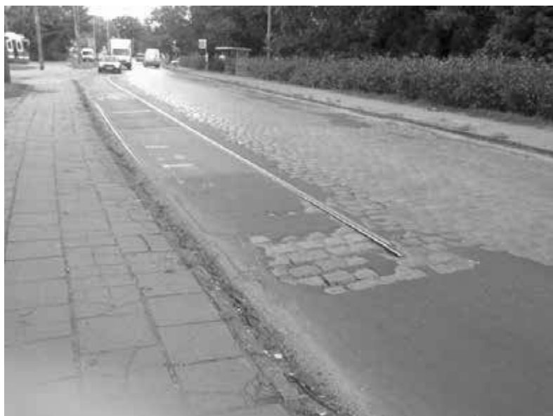
Fot. 56. Nieużywane tory tramwajowe na ul. Przyjaźni Źródło: fot. A. Karaś.
