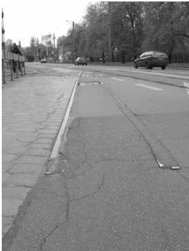
Fot. 4. Pozostałości torów przy dworcu kolejowym Wrocław Wąskotorowy – widok w kierunku mostu Osobowickiego Źródło: fot. M. Smolarski.
