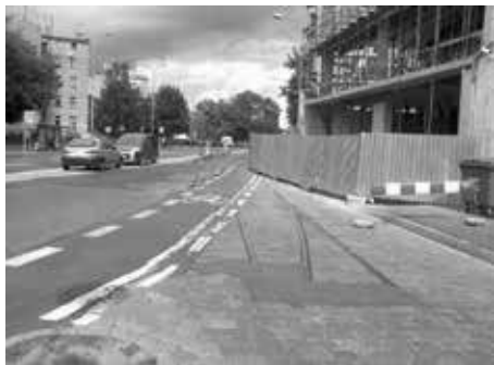
Fot. 26. Nieużywane tory tramwajowe na ul. Rybackiej
