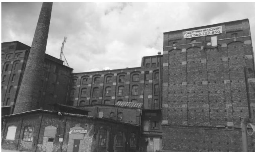
Fot. 14. Kompleks Młyna Sułkowice z widocznym sztyldem „powierzchnie magazynowe” Źródło: fot. P. Gniłka.
