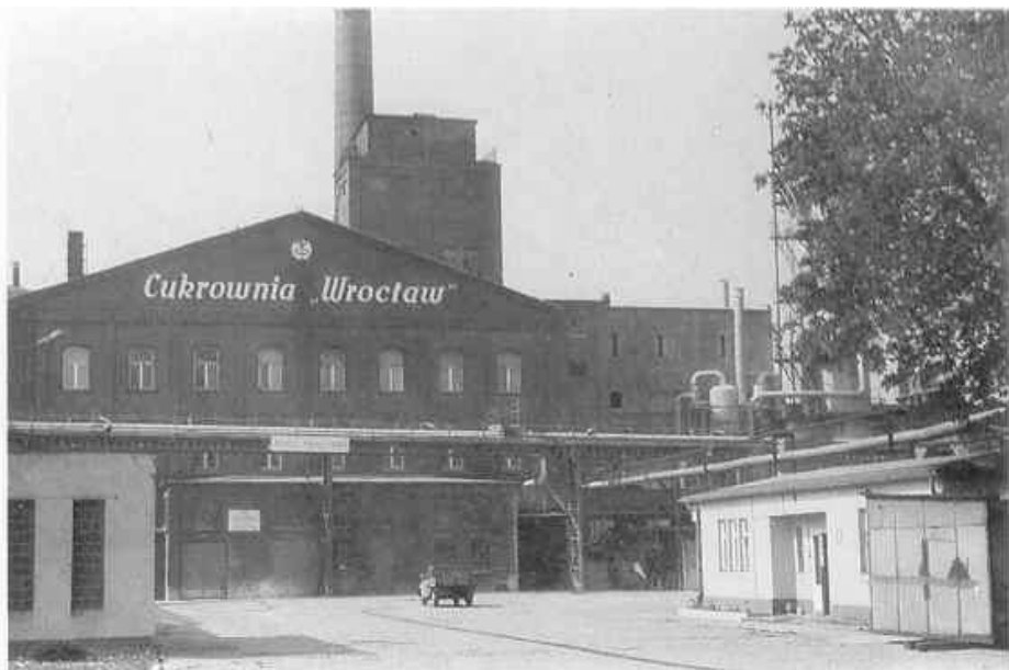
Fot. 17. Wejście główne do Cukrowni „Wrocław” w roku 1985 Źródło: Wratislaviae Amici.
