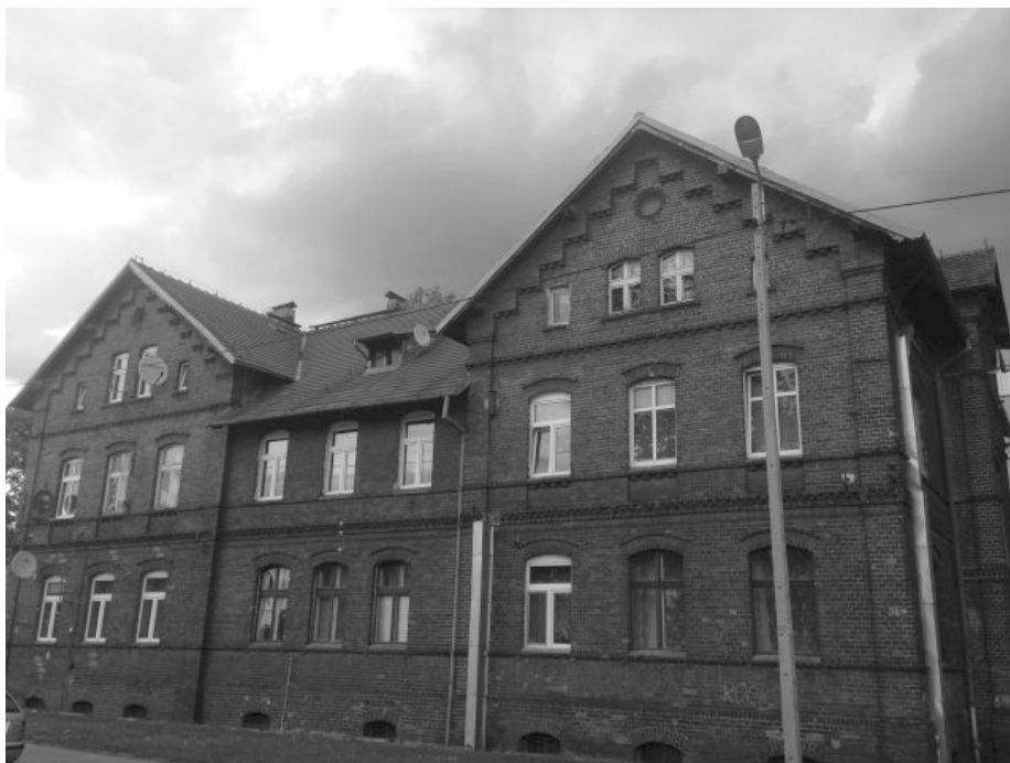
Fot. 21. Budynek mieszkalny w obrębie osiedla pracowniczego przy Cukrowni „Wrocław” Źródło: fot. P. Gniłka.
