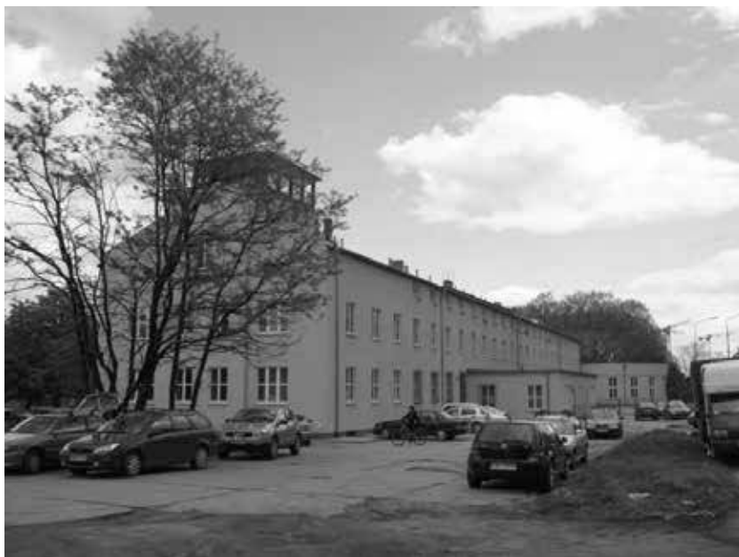
Fot. 19. Terminal odprawy podróżnych na dawnym lotnisku Gądów we Wrocławiu Źródło: fot. M. Smolarski.
