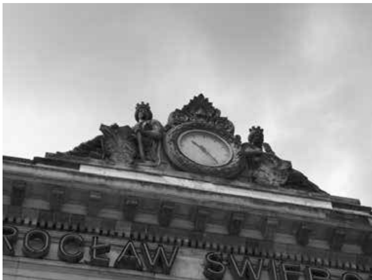
Fot. 9. Zegar nad wejściem głównym do dworca kolejowego Wrocław Świebodzki. Obok zegara alegorie Pomeranii i Silesii Źródło: fot. M. Smolarski.
