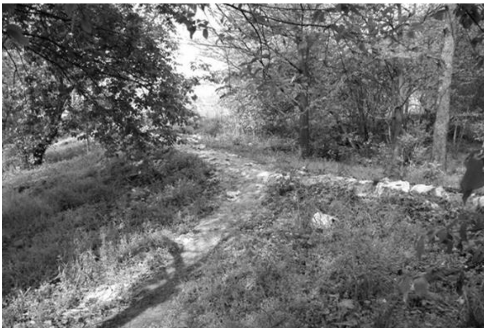
Ryc. 51. Pozostałości tymczasowych umocnień z worków z piaskiem – Szymanów (gm. Wisznia Mała). Źródło: opracowanie własne
