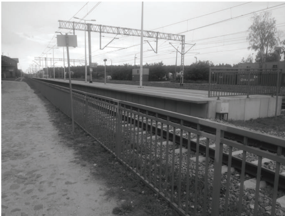
Ryc. 36. Bariery funkcjonalne utrudniające dojście do peronu stacji Gądky w strefie podmiejskiej Poznania od strony głównego osiedla zabudowy mieszkaniowej.
