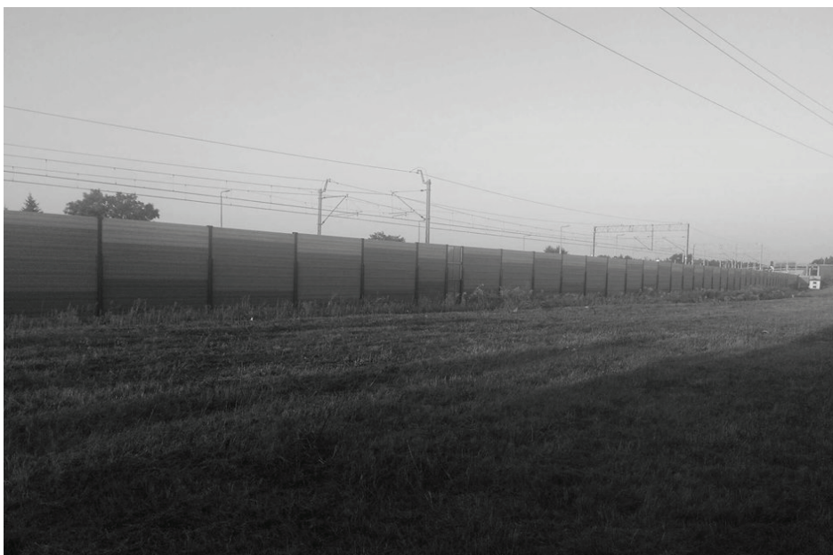
Ryc. 49. Przykład zastosowania ekranów akustycznych w miejscowości Staniątki w strefie podmiejskiej Krakowa. Źródło: Fotografia własna.
