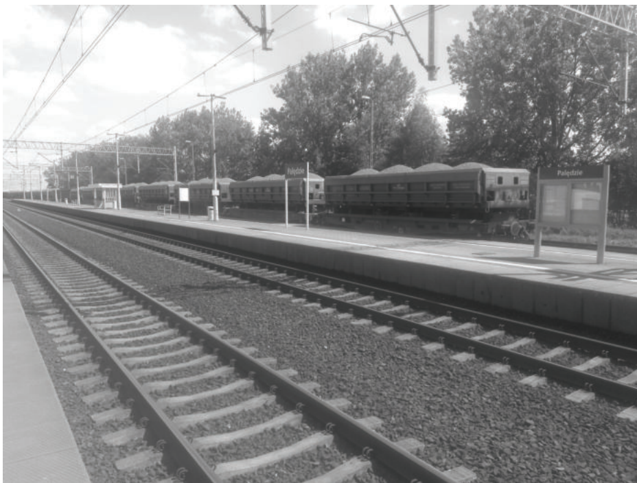
Ryc. 48. Problem wielofunkcyjności linii kolejowych w strefach podmiejskich na przykładzie stacji Pałędzi w strefie podmiejskiej Poznania.
