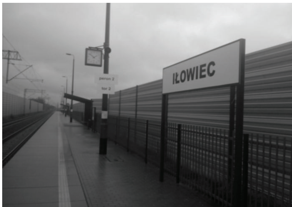
Ryc. 50. Przykład zastosowania ekranów akustycznych w obrębie stacji kolejowej Iłowiec w strefie podmiejskiej Poznania. Źródło: Fotografia własna.
