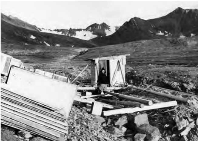
Fot. 4. Rok 1971, budowa stacji – powstają fundamenty (fot. S. Baranowski)
