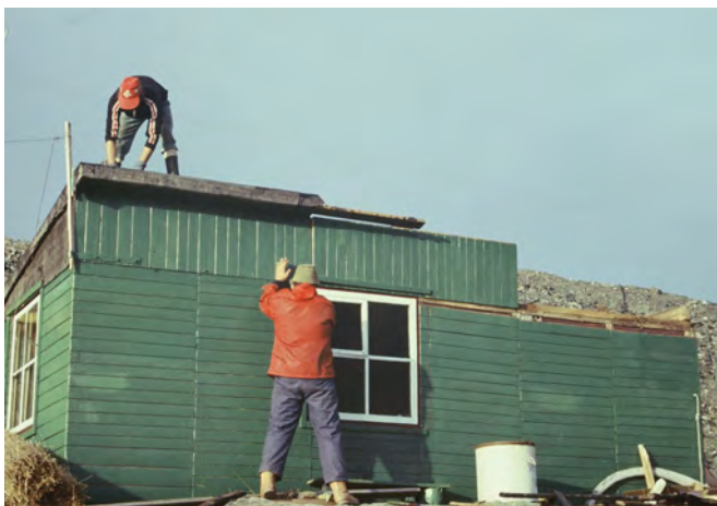
Fot. 14. Początek rozbiórki – tyłem stoi K. Szelest, na dachu J. Kida (fot. M. Sobik)
