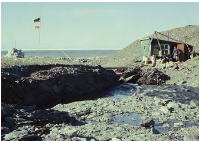
Fot. 12. Lato 1979 – przy- miarka do przebudowy, widoczny zarys kształtu dachu (fot. J. Kida)
