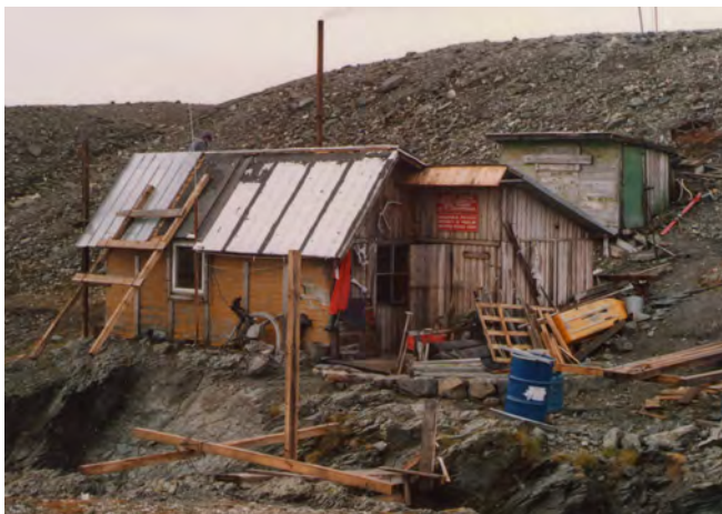
Fot. 44. Remont stacji i budowa nowego mostu na rzece Brattegg (fot. J. Řehák jr)
