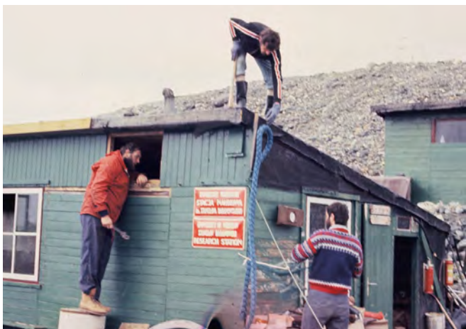
Fot. 13. Początek przebu- dowy Stacji – od lewej: Krzysztof Szelest i Jacek Chachaj, na dachu Janusz Kida (fot. M. Sobik)
