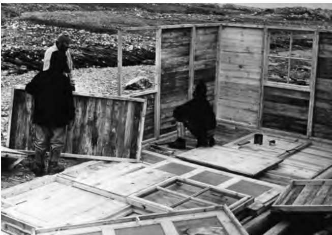
Fot. 5. Dalsze prace konstrukcyjne. W tym czasie w „Baranówce” zamieszkała też Anulka (fot. S. Baranowski)
