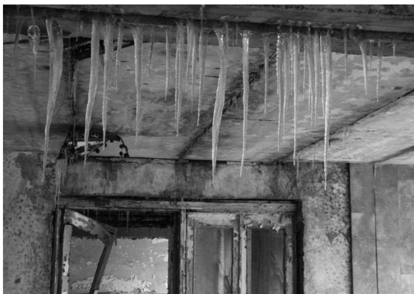
Ryc. 3. Niszczące budynki w mieście Prypeć (fot. P. Krąż)
