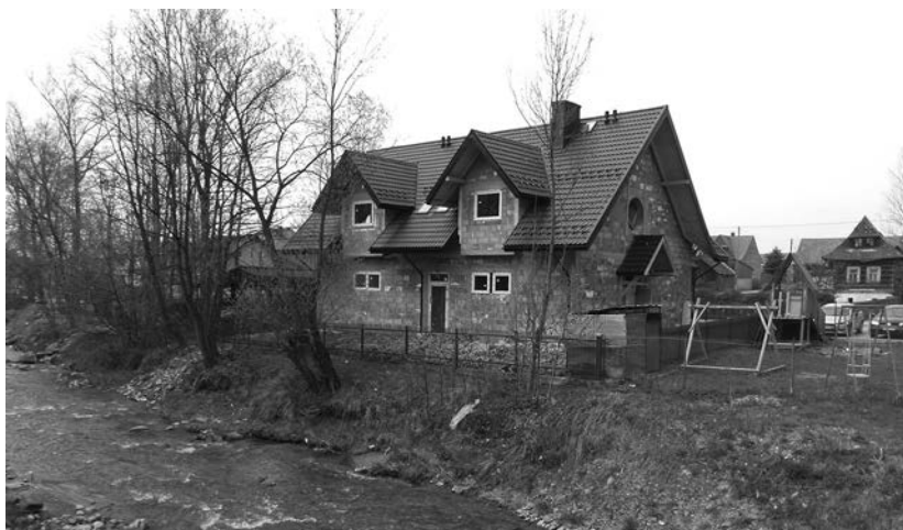
Ryc. 1. Nowy budynek posadowiony na terasie zalewowej Lepietnicy, w granicach korytarza spływu wód powodziowych (fot. Ł. Pyzowski)
