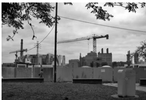
Ryc. 11. Wielki plac budowy Nowego Centrum Łodzi (fot. B. Wycichowska, 2013)
