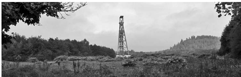
Ryc. 7. Wieża wyciągowa szybu w Parku Regionalnym Scarpe-Escaut (fot. S. Opania)
