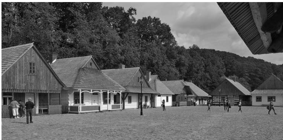
Ryc. 5. Drewniana zabudowa przysłupowa z podcieniami zlokalizowana wokół rynku galicyjskiego. Repliki przedstawione w sektorze miejskim Muzeum Budownictwa Ludowego w Sanoku (fot. M. Oczkoś)
