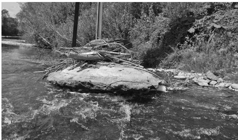
Ryc. 2. Podcięty przez Skawę w wyniku erozji wgłębnej filar kładki pieszej w Juszczyźnie (fot. P. Głuszek)
