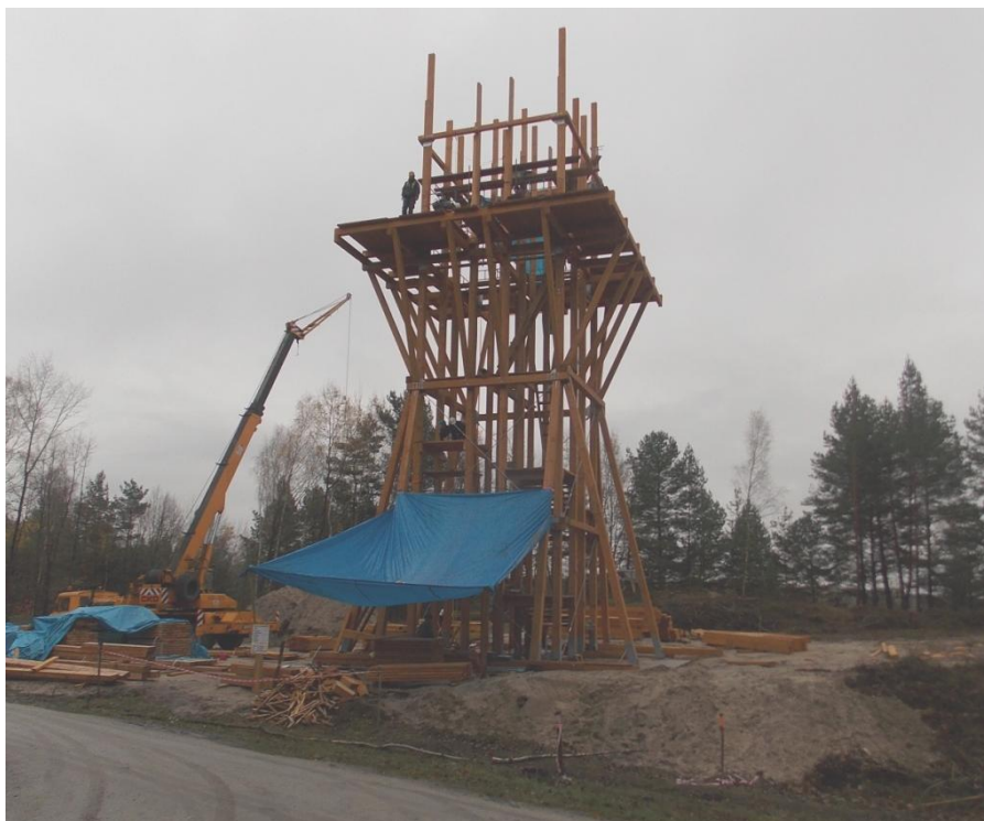
Ryc. 5. Budowa wieży widokowej na geoscieżce „Kopalnia Babina” w Łęknicy - stan na XI 2013 r. Autor: M. Suszczewicz.
